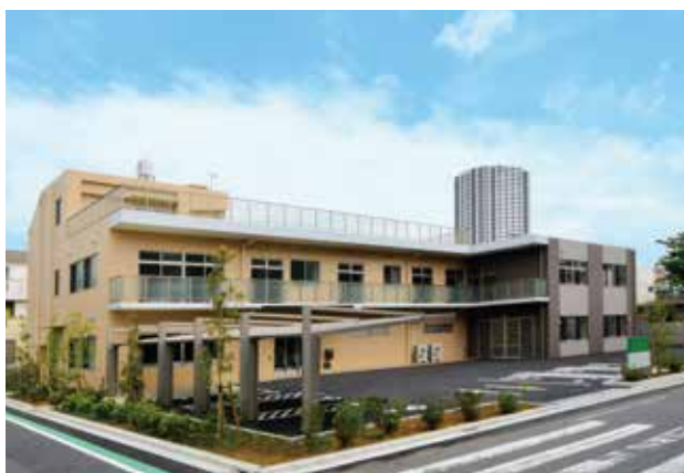
▲東京都葛飾福祉工場・金町工場本館
